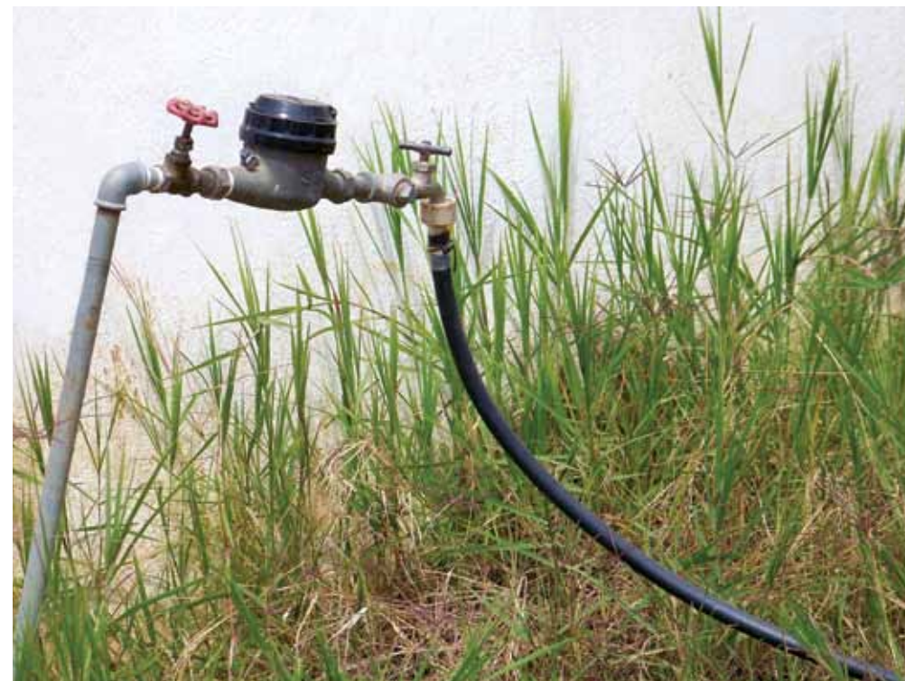
Hidrante Comunitario en Delegación Norte, Zona Periurbana de Xalapa
